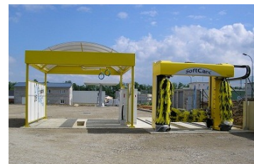
Aire de lavage automobile
