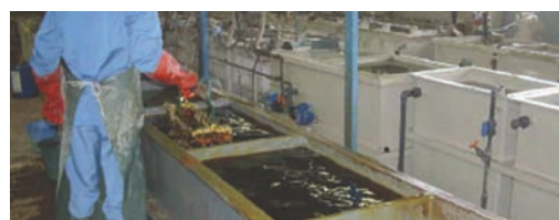
Cuves de traitement de surface
