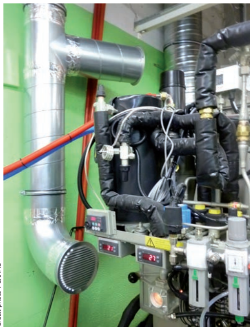
Ventilation en point bas dans un pressing fonctionnant au K4
