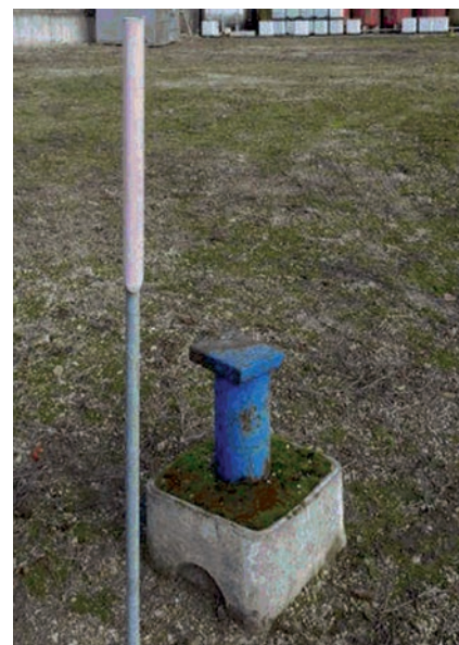
Piezomètre pour le prélèvement d'eaux souterraines
