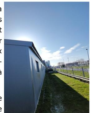
*Toiture inclinée rejetant les eaux de pluies dans la noue d'infiltration*
