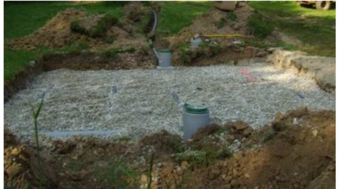
Mise en place d'un assainissement non collectif
