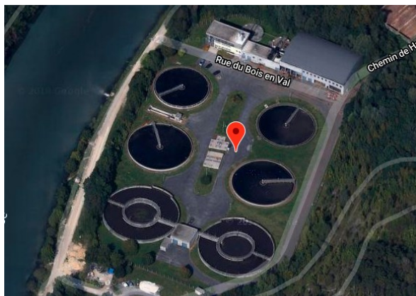
Station d'épuration Charleville-Mézières
