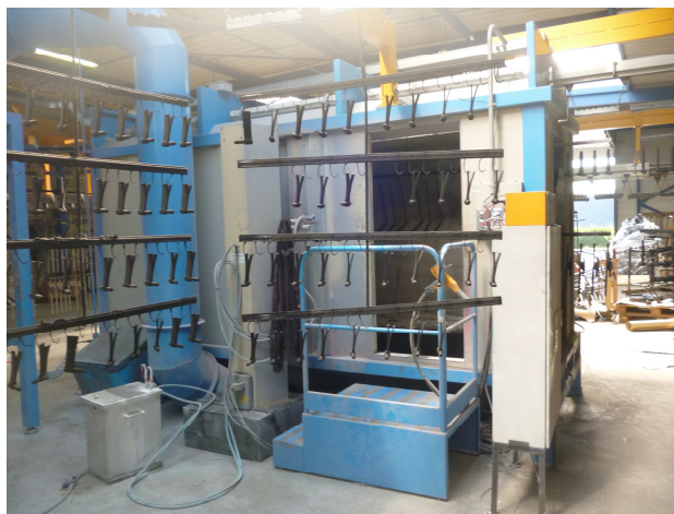
Application de peinture sur pièces métalliques
