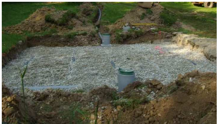
Mise en place d'un assainissement non collectif
